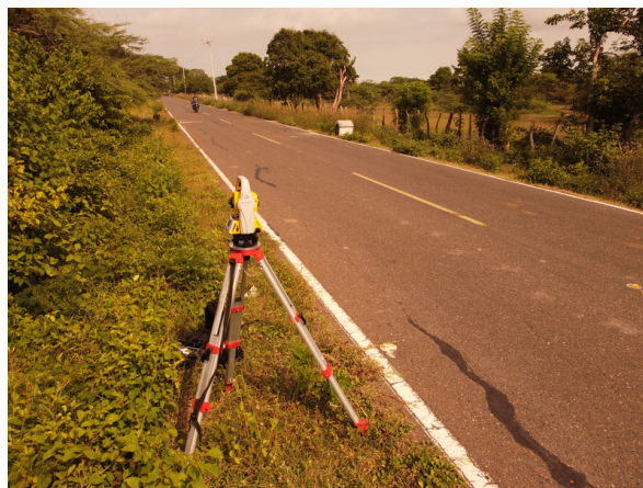
Levantamiento topográfico en vía
